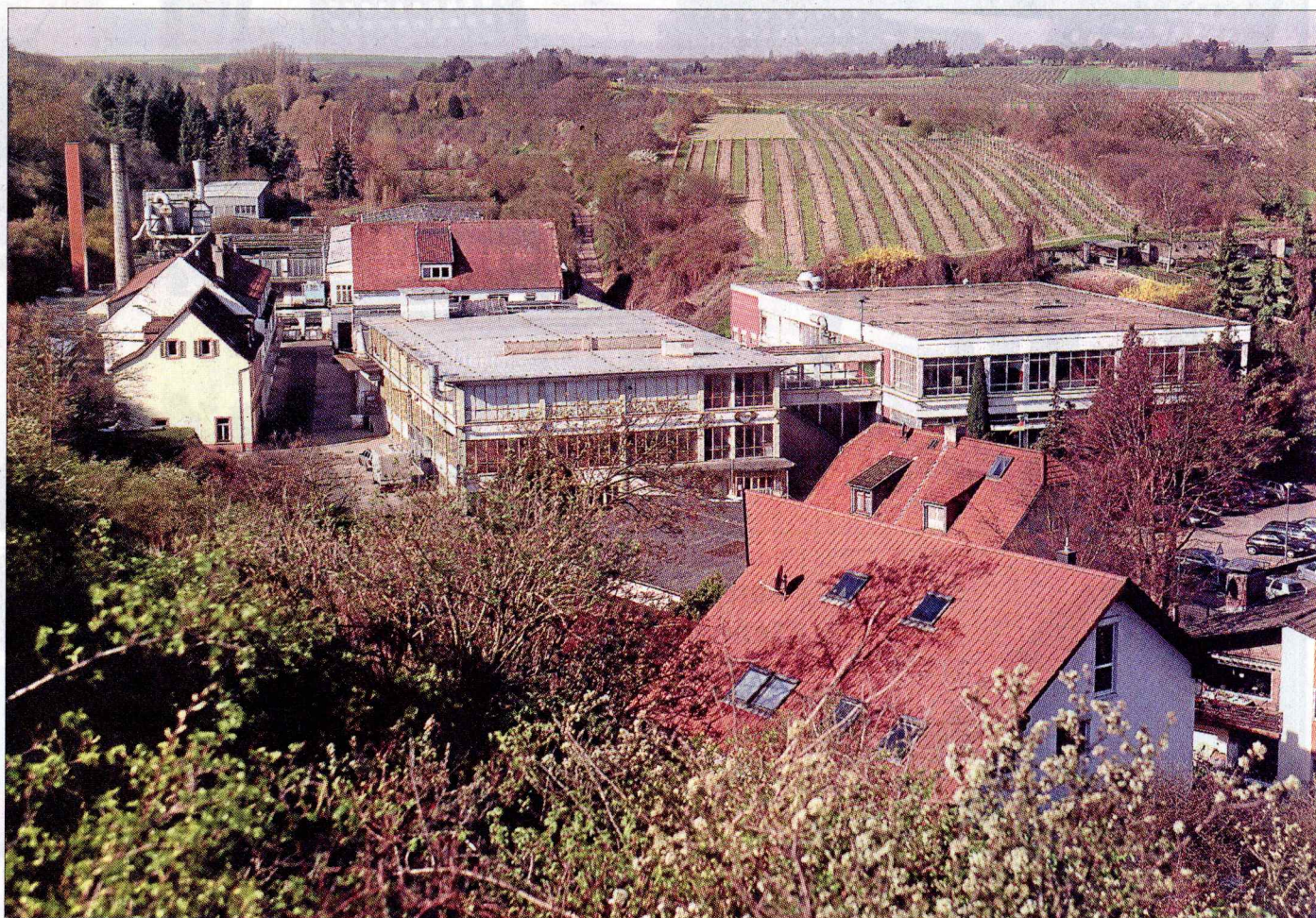
Die Kapselfabrik hat in Nackenheim Tradition. Schon die Familie des Schriftstellers Carl Zuckmayer war hier aktiv, sein Geburtshaus steht auf dem Firmengelände. Was mit der Fläche geschieht, steht in den Sternen. ■ Foto: Harry Braun
